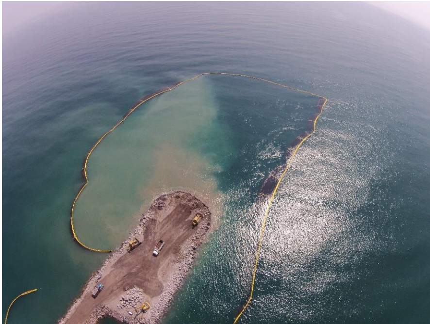
Figura 3. Confinamiento de sedimentos mediante las mallas antidispersión de sedimentos durante el mes de agosto, 2015. (Foto: APIVER).
